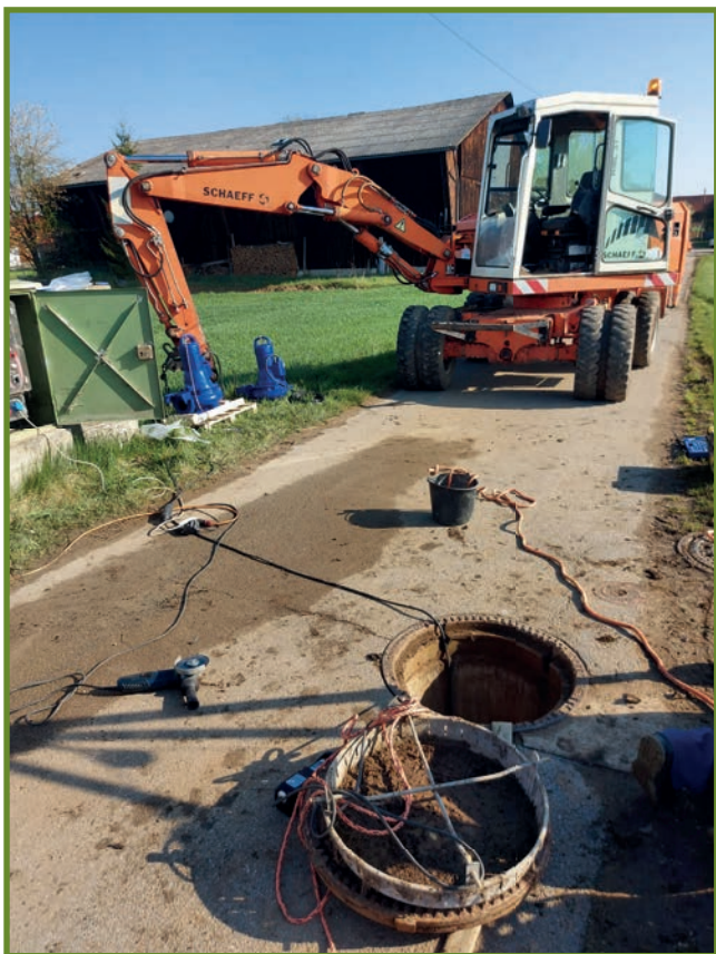
Ein neues Pumpenrohr wird von einer Stahlbaufirma vor Ort passgenau gefertigt.
