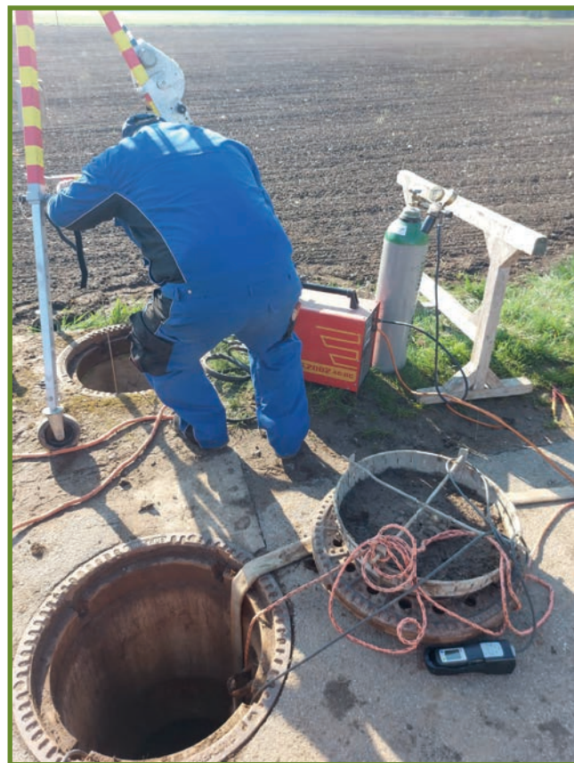
Einbau des neuen Pumpenrohres, der Schacht ist etwa 5 mtr. tief.
