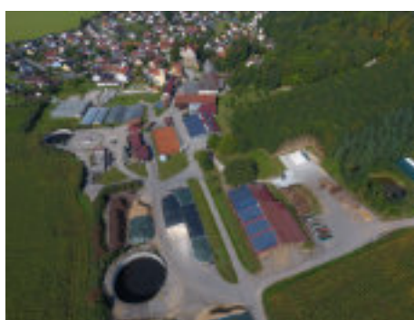
Hühnermobil der Familie Hermann in Wohlfest Luftaufnahme der Biogas Anlage in Wolfring
